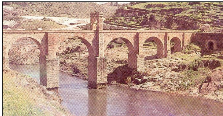
10. Puente de Alcántara. Cáceres.
