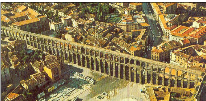
11. Acueducto de Segovia, vista aérea.
